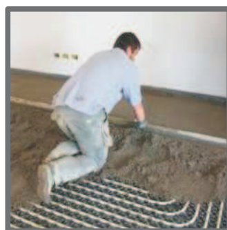
Addetto durante la fase di staggiatura del massetto premiscelato.
