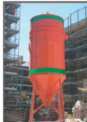
Silos per la realizzazione di massetto premiscelato.
