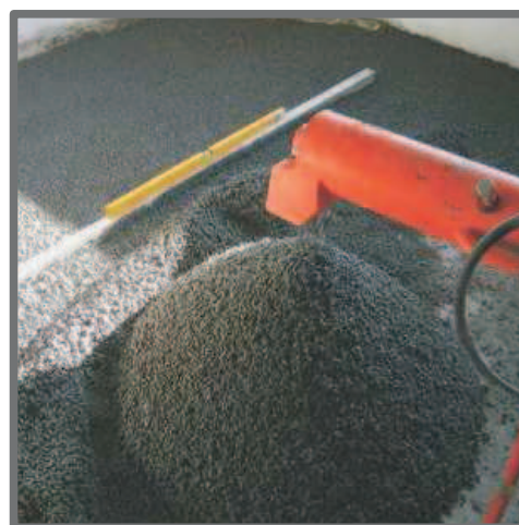
Dettaglio dell'applicazione dell'argilla espansa.
